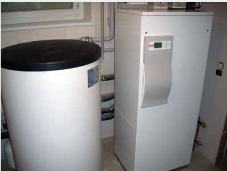
Roth Wärmepumpe TerraCompact® E* 8 kW, Einfamilienhaus, Pattensen, Deutschland
